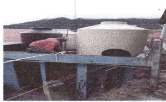
Foto 12: Sustitución de accesorios deposito de agua.
