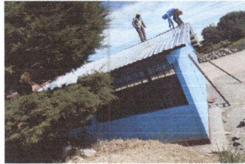
Foto 2: Sustitución de capote para lamina troquelada.
