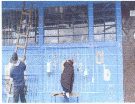
Foto 7: Sustitución de balcones.
