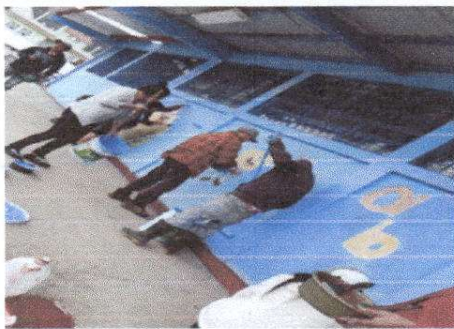
Foto 9: Pintura en muros exteriores e interiores.
