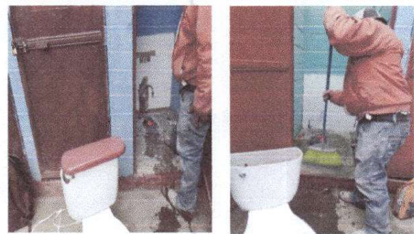
Foto 10: Sustitución de inodoro.
