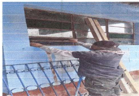
Foto 6: Sustitución de vidrios.
