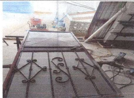
Foto 4: mantenimiento a estructura ( lijado, cambio de tubo, cepillado, sujeciones).
