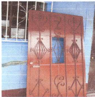
Foto 3: Sustitución de puertas.
